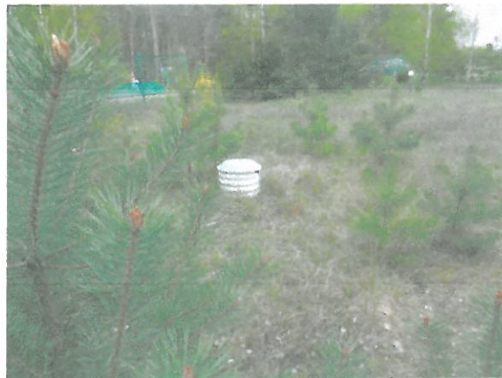
Szambo zlokalizowane na działce
