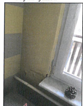
Ubytki tynków
