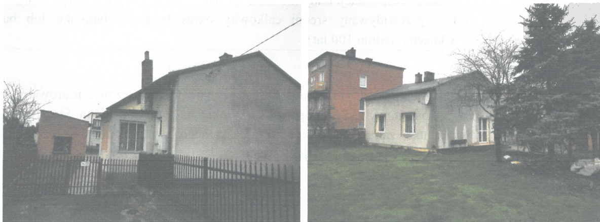
Zdjęcia 10-13: Budynek mieszkalny z zewnątrz.
