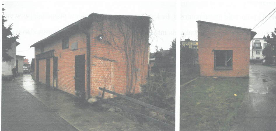
Zdjęcia 14-15: Budynek gospodarczy z zewnątrz.
